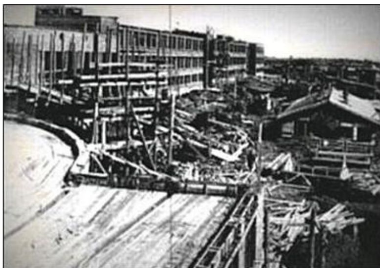
Строительство первой очереди Барнаульского меланжевого комбината. Главный корпус. Фото 1933 года
