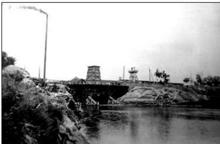
Мост через Барнаулку на Красноармейском проспекте. Фото 1940-х гг.
