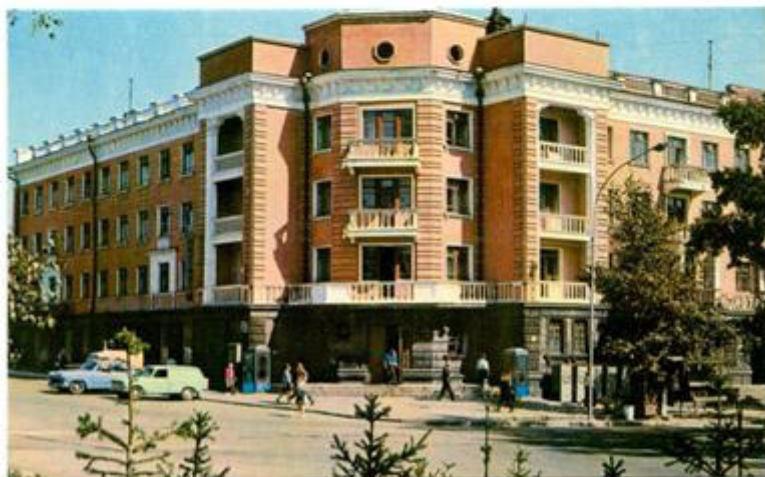
Гостиница «Алтай», построенная в 1938-1941 г.г. Архитектор А.В.Баранский. (пр. Ленина, 24 / ул. Анатолия, 84) Фото Б.Подгорного, 1971 г.
