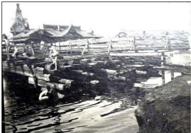
В 1928 г. имело место сильное наводнение, по размерам, напоминающим наводнение 1793 г. На снимках мост на р. Барнаулке в районе старого базара, разрушенный паводком. Фото из фондов ГААК. Ф.Р-166. Оп.1. Д.86.
