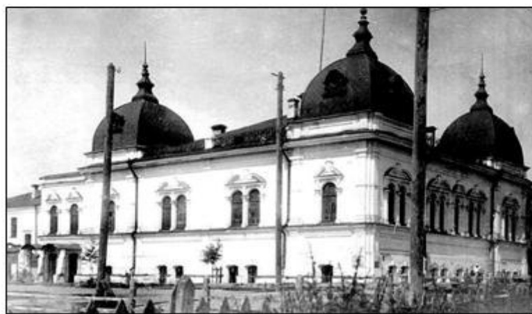
Здание бывшего духовного училища, восстановленное в 1923 г. после пожара 1917 года. При реконструкции по проекту архитектора П.П. Курковского был изменен внешний вид здания устройством трех куполообразных башен. Фото 1930-х годов.
