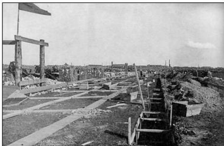
Строительная площадка Барнаульского меланжевого комбината. Фото 1932 г. П.А.Казанского из фондов АГКМ
