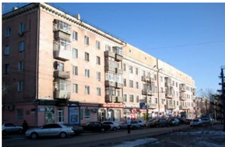
Жилой дом постройки 1938-1940 г.г (Дом Крайисполкома). Архитектор А.В.Баранский. На первом этаже находится аптека № 1, детсад № 241 и др. (пр. Ленина, 28 / ул. Пролетарская, 67). Фото автора, 2007 г.
