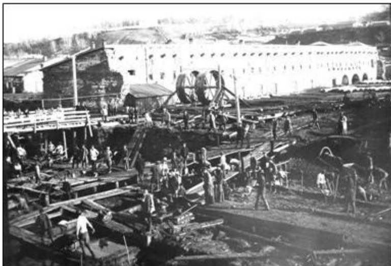
Строительство моста на реке Барнаулке. Фото 1928 г. Г.А.А.К. Ф.Р.-166. Оп.1. Д.86.
