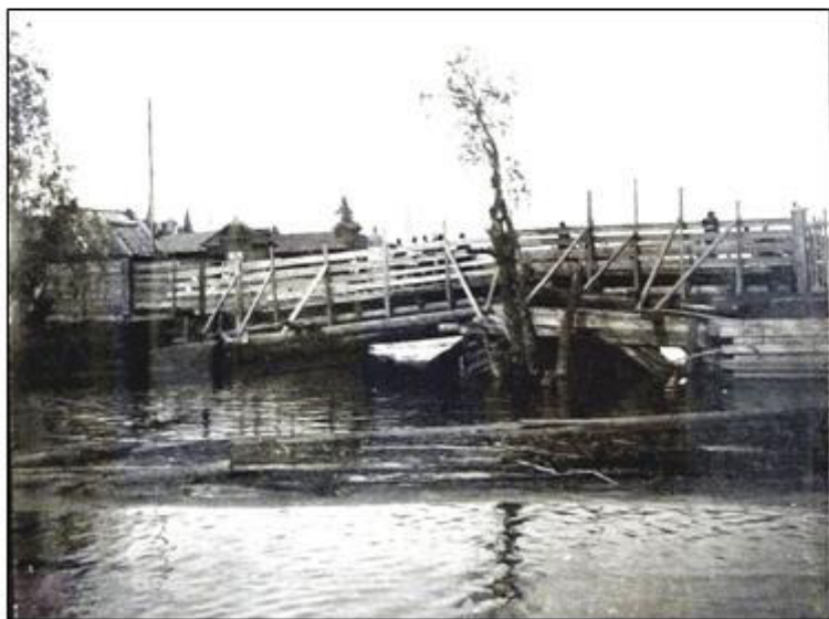
В 1928 г. имело место сильное наводнение, по размерам, напоминающим наводнение 1793 г. На снимках мост на р. Барнаулке в районе старого базара, разрушенный паводком. Фото из фондов ГААК. Ф.Р-166. Оп.1. Д.86.
