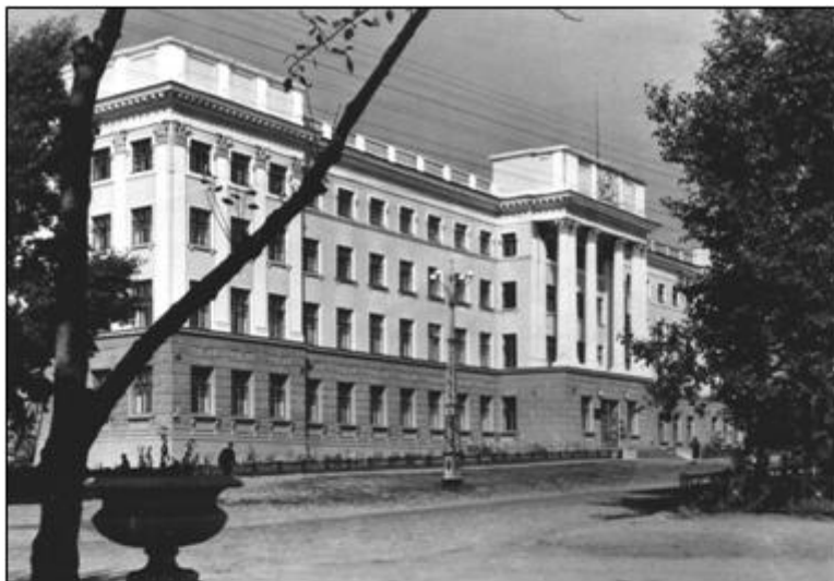
Здание Алтайского крайкома КПСС, построенное в 1939-1943 гг. Архитекторы А.В.Баранский, В.Л.Казаринов. (Пр. Ленина, 25). Фото 1949 г. Н.Н.Калинина из фондов АКУНБ
