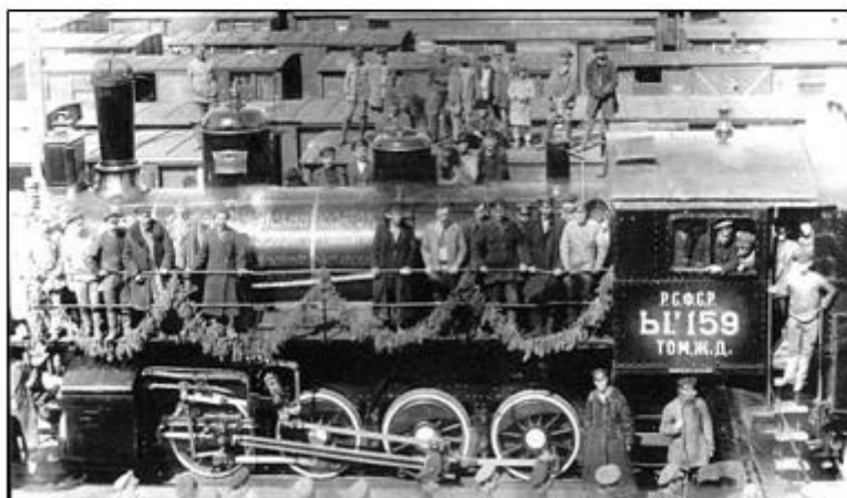
1 мая 1922 г. работники Главных ремонтных мастерских отремонтировали к празднику сверх плана паровоз «Бу-159» и выпустили его в эксплуатацию.
