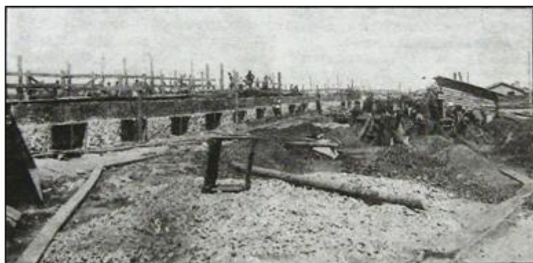
На строительстве меланжевого комбината. 1932 г. Фото П.А.Казанского из фондов АГКМ
