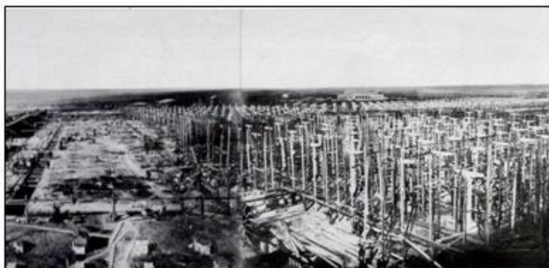
Панорама строительства меланжевого комбината. 1932 г. Фото П. А. Казанского из фондов АГКМ
